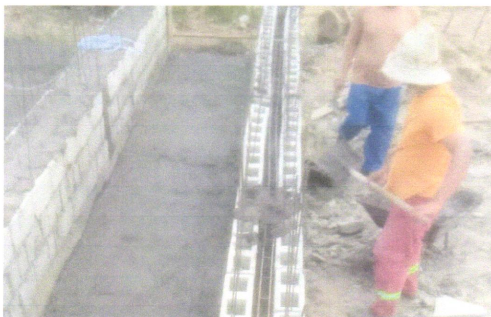
Foto 04 - (COMPOSIÇÃO REPRESENTATIVA) EXECUÇÃO DE ESTRUTURAS DE CONCRETO ARMADO, PARA EDIFICAÇÃO INSTITUCIONAL TÉRREA, FCK
