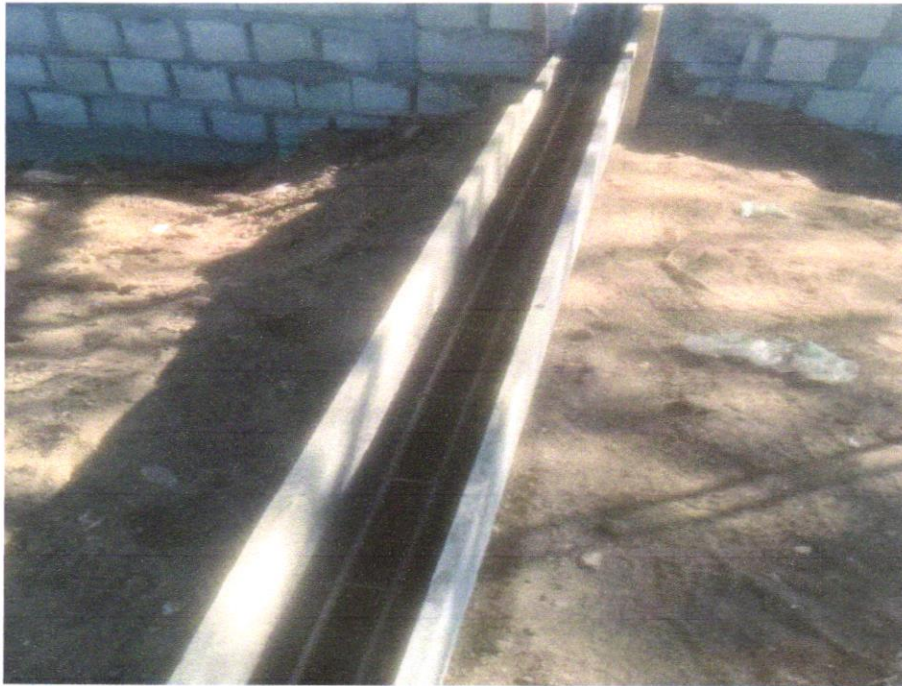
Foto 07 - (COMPOSIÇÃO REPRESENTATIVA) EXECUÇÃO DE ESTRUTURAS DE CONCRETO ARMADO, PARA EDIFICAÇÃO INSTITUCIONAL TÉRREA, FCK
