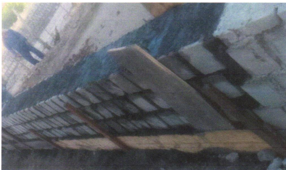
Foto 03 – ALVENARIA DE BLOCOS DE CONCRETO ESTRUTURAL 14X19X39 CM, (ESPESSURA 14 CM) FBK = 14,0 MPA, PARA PAREDES COM ÁREA LÍQUIDA MENOR QUE 6M², SEM VÃOS, UTILIZANDO PALHETA. AF_12/2014
