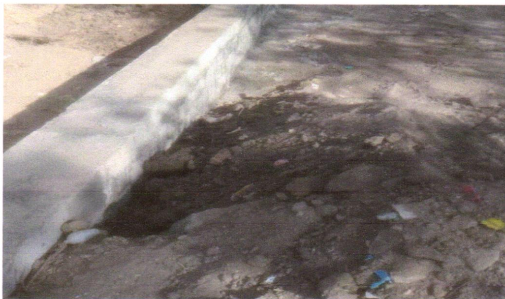
Foto 06 - ALVENARIA DE BLOCOS DE CONCRETO ESTRUTURAL 14X19X39 CM, (ESPESSURA 14 CM) FBK = 14,0 MPA, PARA PAREDES COM ÁREA LÍQUIDA MENOR QUE 6M 2 , SEM VÃOS, UTILIZANDO PALHETA. AF_12/2014
