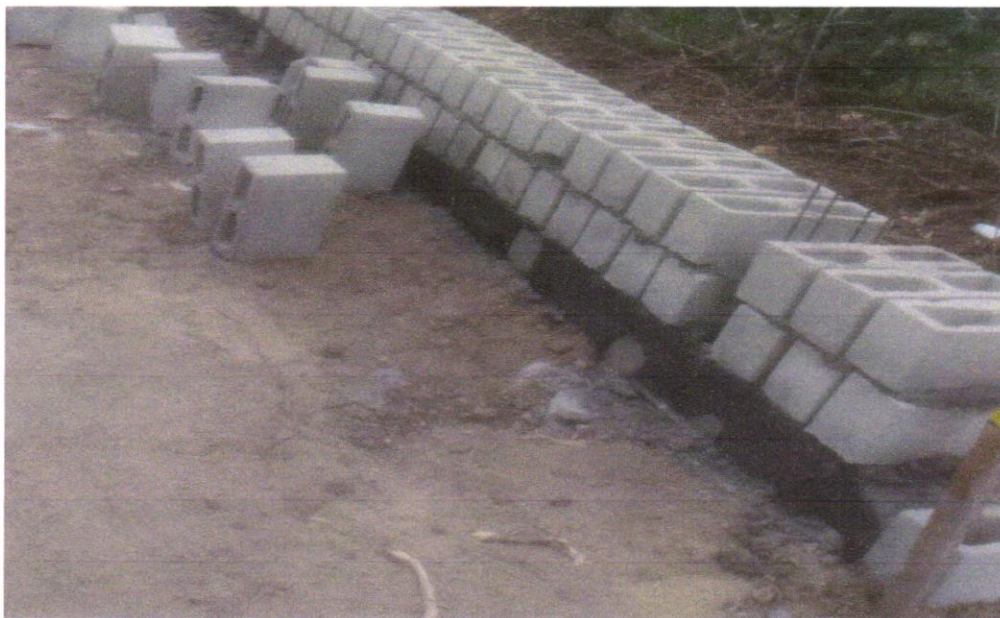
Foto 05 - ALVENARIA DE BLOCOS DE CONCRETO ESTRUTURAL 14X19X39 CM, (ESPESSURA 14 CM) FBK = 14,0 MPA, PARA PAREDES COM ÁREA LÍQUIDA MENOR QUE 6M 2 , SEM VÃOS, UTILIZANDO PALHETA. AF_12/2014
