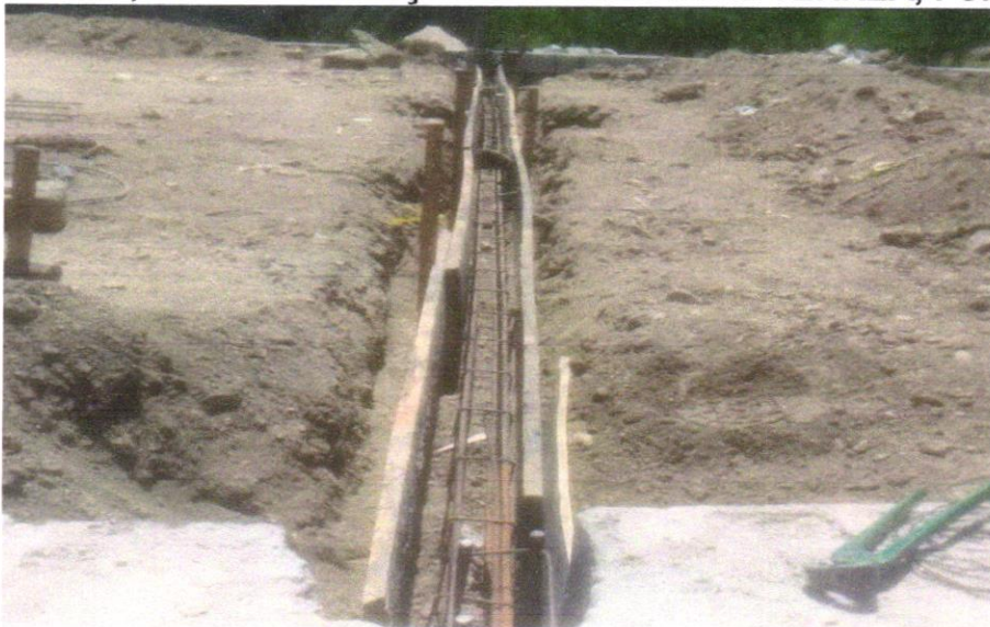
Foto 08 - (COMPOSIÇÃO REPRESENTATIVA) EXECUÇÃO DE ESTRUTURAS DE CONCRETO ARMADO, PARA EDIFICAÇÃO INSTITUCIONAL TÉRREA, FCK
