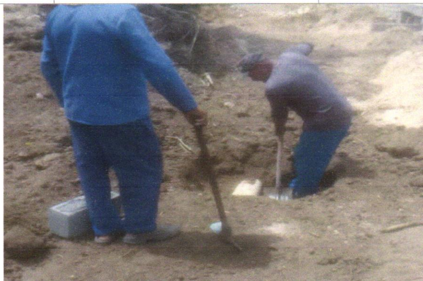
Foto 01 - ESCAVAÇÃO MANUAL DE VALA COM PROFUNDIDADE MENOR OU IGUAL A 1,30 M
